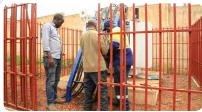
Mafundi wa TANESCO wakiendelea na kazi ya kufunga mashineumba (Transfoma) katika moja ya migodi ya dhahabu katika Wilaya ya Nyang'hwale.
