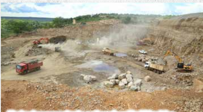
Kazi ya kupasua miamba na kuondoa vifusi ikiendelea kulingana na Mpangokazi wa utekelezaji wa ujenzi wa mradi wa bwawa la kuzalisha umeme.
