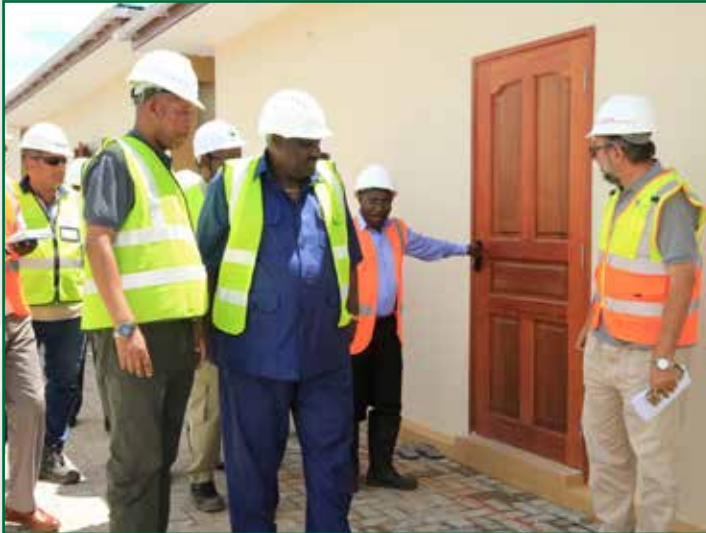
Waziri wa Nishati, Dkt. Medard Kalemami (wa pili-kulia) akikagua ubora wa kitasa cha mlango wa moja ya nyumba za kuishi wafanyakazi zilizokamilika kujengwa katika mradi wa Umeme wa Julius Nyerere (JNHPP).
