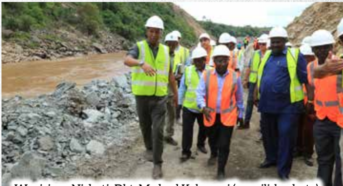
Waziri wa Nishati, Dkt. Medard Kalemani (wa pili-kushoto) akikagua sehemu ya eneo litakapojengwa bwawa la kuzalisha umeme katika bonde la mto Rufiji.
