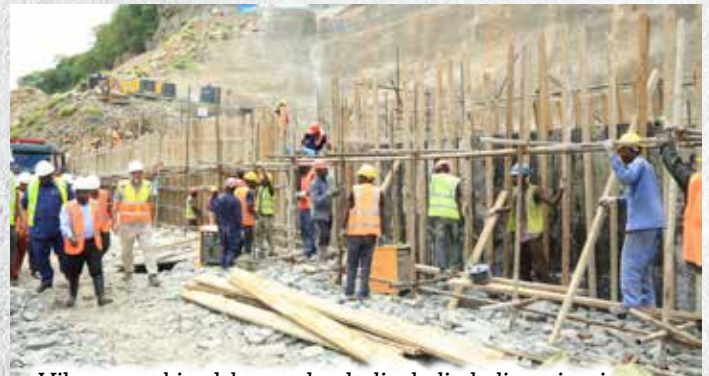
Vibarua wakiendelea na shughuli mbalimbali za ujenzi kulingana na Mpangokazi wa utekelezaji wa ujenzi wa mradi wa bwawa la kuzalisha umeme.
