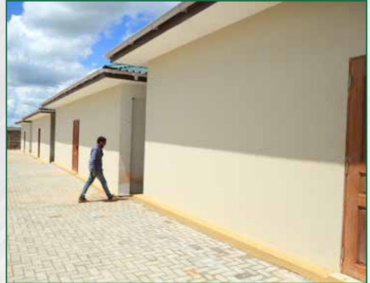
Muonekano wa baadhi ya nyumba za wafanyakazi wanaotekeleza mradi wa Umeme wa Julius Nyerere (JNHPP) zilizokamilika kujengwa katika eneo la mradi.
