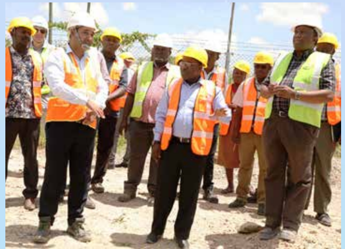
Waziri wa Nishati Dkt Medard Kalemmani (katikati), akitoa maelekezo kwa mkandarasi (Kampuni ya KCE) anayetekeleza mradi wa upanuzi wa kituo cha kupoza umeme Zuzu, Dodoma, alipofanya ziara kukagua maendeleo ya mradi huo, Februari 19, 2020.
