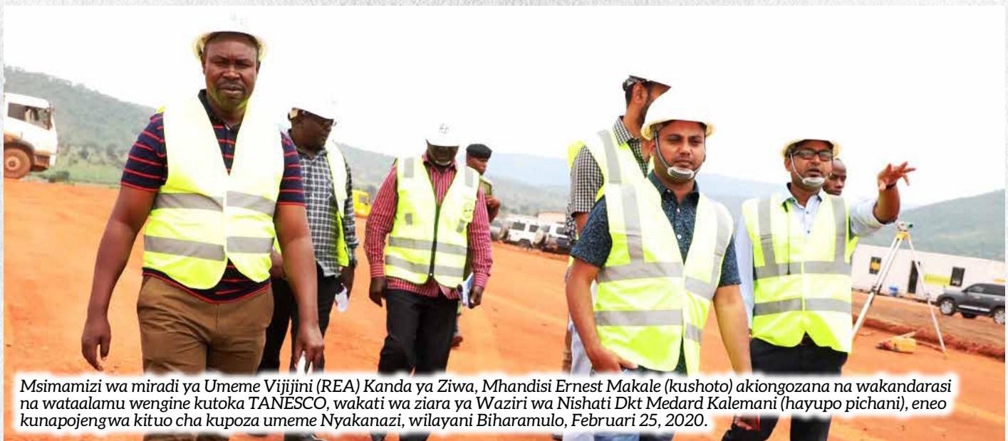
Kazi ya ujenzi wa kituo cha kupoza umeme Nyakanazi wilayani Biharamulo ikiendelea. Taswira hii ilichukuliwa wakati wa ziara ya Waziri wa Nishati Dkt Medard Kalemmani kujionea maendeleo ya mradi huo, Februari 25 mwaka huu.
