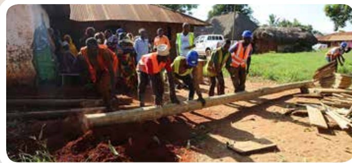
Mafundi wakiwa wanaendelea na kazi ya uwekaji nguzo za umeme, kata ya Mkange, Wilaya ya Bagamoyo, Mkoa wa Pwani, wakati wa ziara ya Naibu Waziri wa Nishati, Subira Mgalu (hayupo pichani), hivi karibuni.
