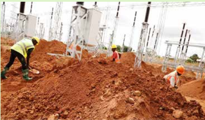
Mafundi wakiendelea na kazi za ujenzi wa kituo cha kupoza umeme Singida. Taswira hii ilichukuliwa wakati wa ziara ya Waziri wa Nishati Dkt Medard Kalemmani (hayupo pichani), Aprili 18, 2020.
