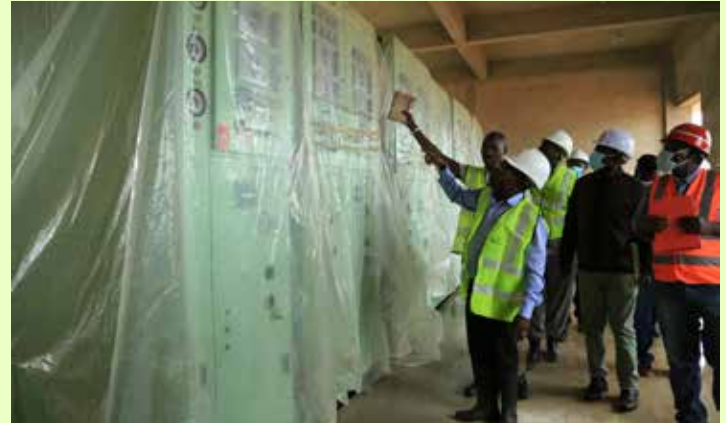
Waziri wa Nishati, Dkt. Medard Kalemani (katikati) akikagua mashine zilizofungwa ndani ya jengo la kuendeshea mitambo (Control Room) katika Kituo cha kupoza na kusambaza umeme cha Mponvu mkoani Geita baada ya kufanya ziara ya kukagua maendeleo ya ujenzi wa kituo hicho hivi karibuni.
