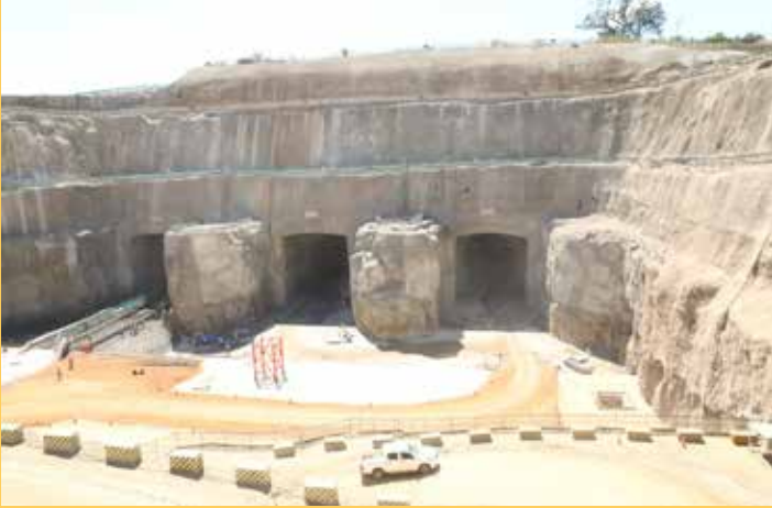
Sehemu ya ujenzi wa mradi wa umeme wa maji Julius Nyerere ukiendelea ambapo baada ya kukamilika utazalisha umeme wa kiasi cha megawati 2115.
