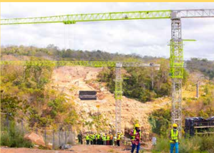
Sehemu ya ujenzi wa daraja la kudumu ukiendelea, daraja hilo litakuwa la pili kwa ukubwa katika Mto Rufiji likitanguliwa na lile la Mkapa.
