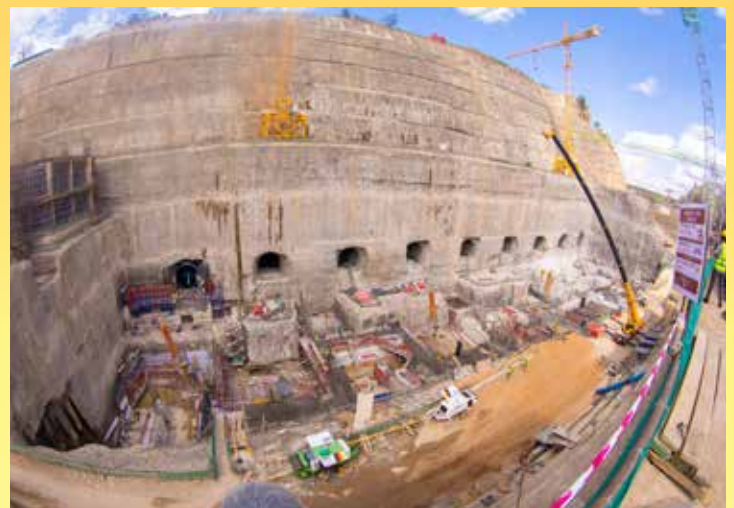
Ujenzi ukiendelea katika Mahandaki Tisa ya kupekeleka maji katika mitambo ya kuzalisha umeme katika mradi wa Julius Nyerere (JNHPP).
