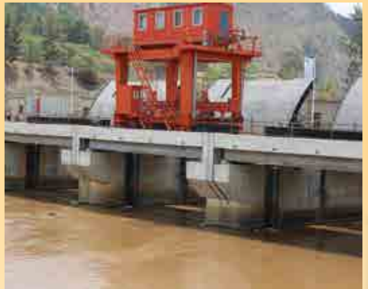
Muonekano wa milango ya kudhibiti maji katika eneo la mradi wa kuzalisha umeme wa maji wa Rusumo MW 80 uliopo wilayani Ngara mkoani Kagera.
