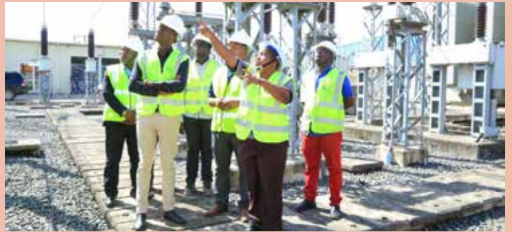
Msimamizi wa Kituo cha Kusambaza Umeme cha Mbagala, Mhandisi Neema Ngogo( wa pili kulia) , akimuonyesha Naibu Waziri wa Nishati, Wakili Stephen Byabato( wa pili kushoto) namna ambavyo umeme unapokelewa, kupozwa na kusambazwa kituoni hapo, wakati wa ziara ya kutembelea kituo hicho Jijini Dar es salaam, Desemba 16, 2021.
