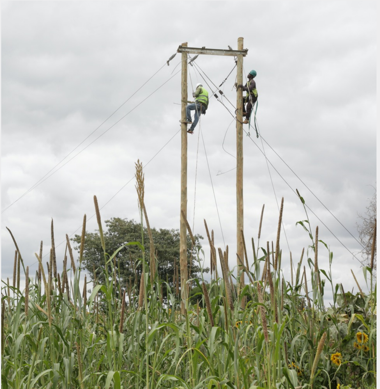
Mafundi wakiendelea na kazi ya kuunganisha nyaya ili kusambaza umeme kwa wananchi.
