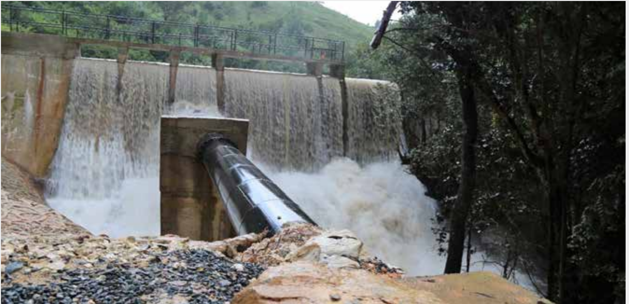
Miundombinu ya Mradi wa kuzalisha umeme kwa kutumia maporomoko ya maji ya Mto Ijangala, uliopo katika kijiji cha Masisiwe, Wilaya ya Makete, Mkoa wa Njombe. Mradi huu umefadhiliwa na Serikali kupitia Wakala wa Nishati Vijijini pamoja na wadau wengine na utazalisha umeme wa kilowati 360. Mradi huu unaratajiwa kuzinduliwa tarehe 24 Mei, 2023.
